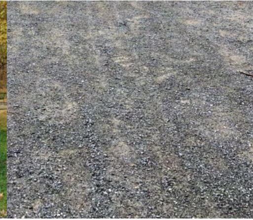
informele parkpaden, gestabiliseerde halfverharding type Stabilizer, kleur 'Hansa mix' (Ecodynamic) met opsluitbanden (uit het zicht)
