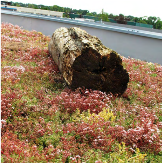
Natuurdak, inheemse planten, extensief dak, enkele lichtgewicht boomstronken, dood hout voor nestgelegenheid bijen, biodivers groendak lichtgewicht (Leverancier sempergreen)
