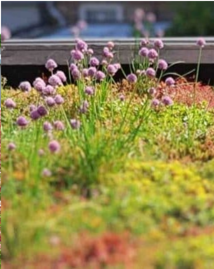
Natuurdak, inheemse planten, extensief dak, enkele lichtgewicht boomstronken, dood hout voor nestgelegenheid bijen, biodivers groendak lichtgewicht (Leverancier sempergreen)
