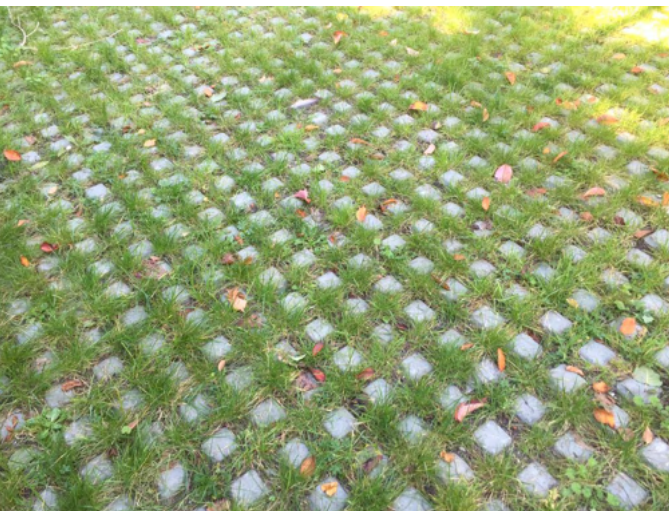
rijweg gesloten verharding BSS, kleur lichtgrijs groen parkeren, grassplittegel (Bosch beton), kleur grijs, 62,5x37,5x15cm (afh. van bodem/infiltratieonderzoek)
