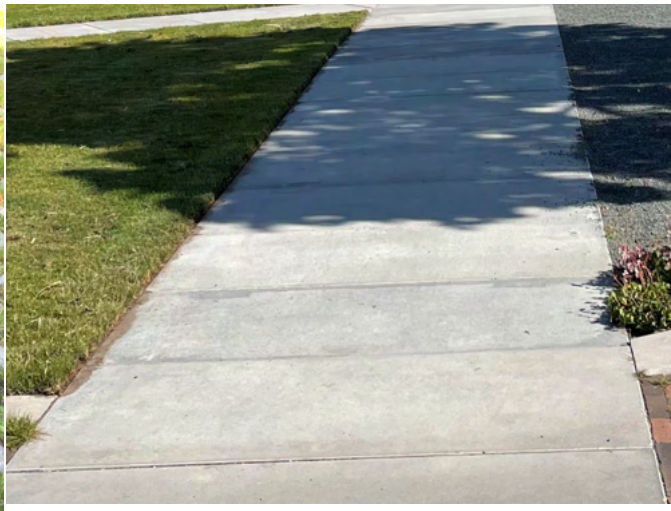
toegangspaden, betonnen grootformaat tegels, formaat kleur lichtgrijs, 80 x120cm (Leverancier Esticon, Meteocon beton)
